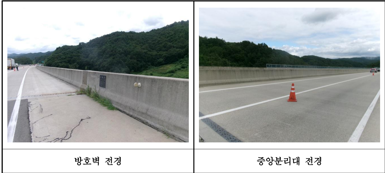
【사진 11.3.51】 방호벽 및 중앙분리대 전경
