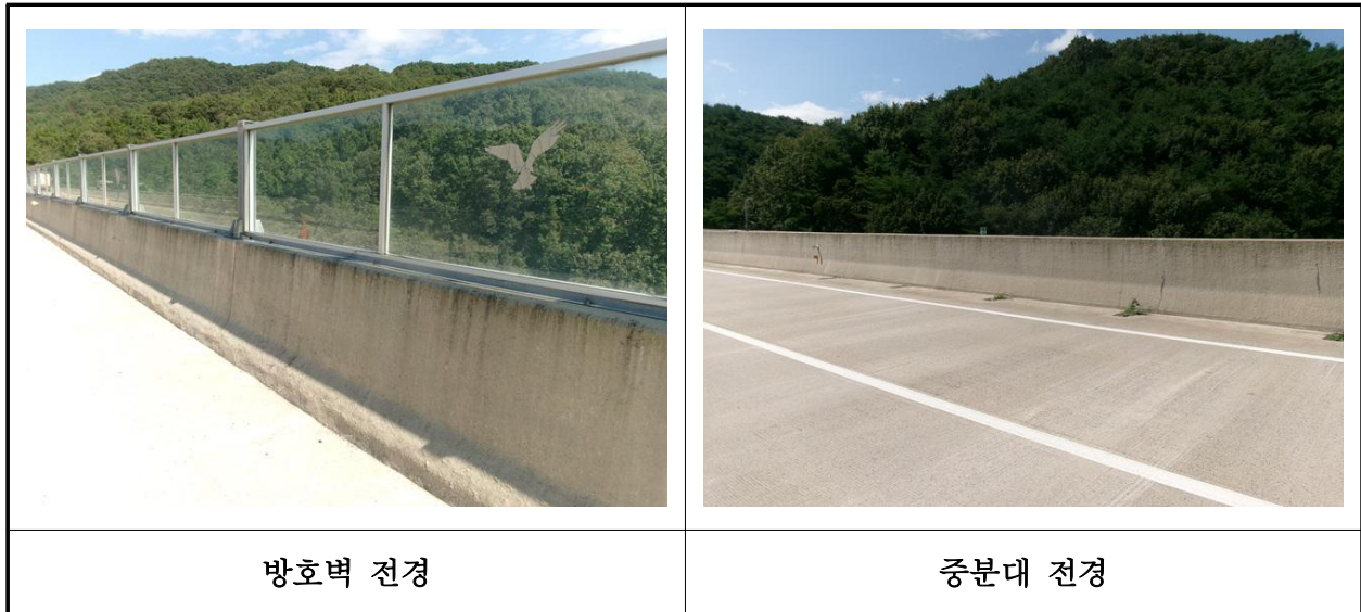
【사진 11.3.24】 방호벽 및 중앙분리대 전경
