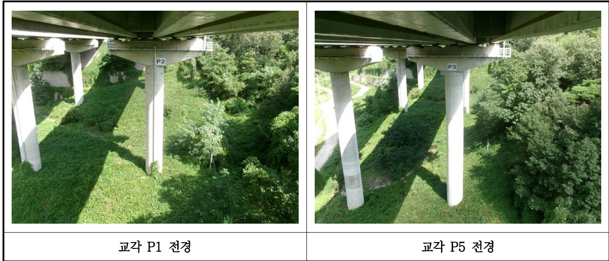
【사진 11.3.10】 교각 전경
