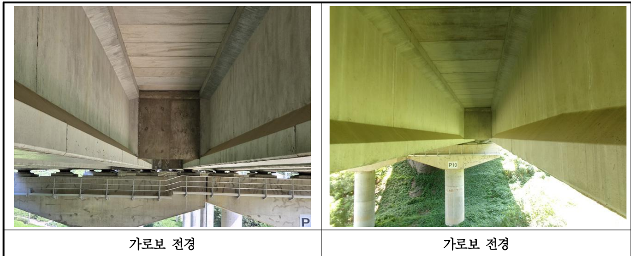
【사진 11.3.33】 가로보 전경
