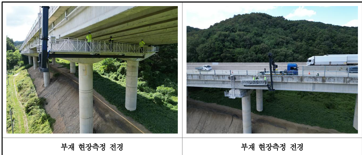
【사진 11.2.1】 부재 현장측정 전경
