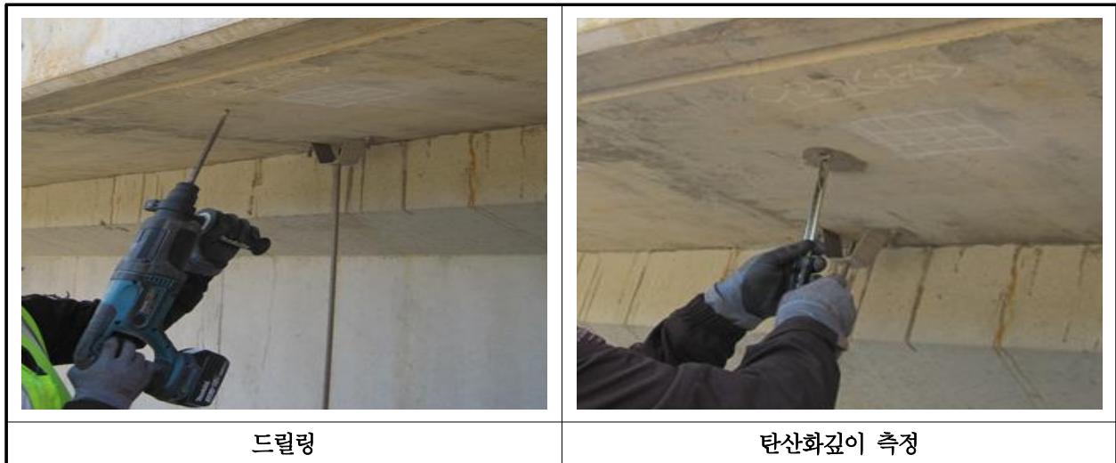
【사진 11.4.3】 탄산화 깊이 측정 현장사진
