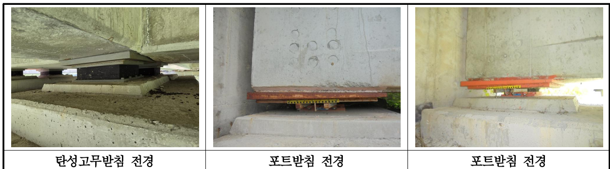
【사진 11.3.40】 교량받침 전경
