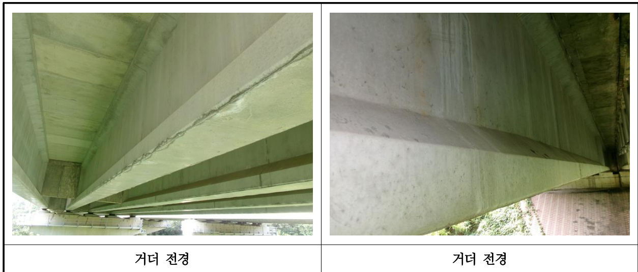
【사진 11.3.4】 거더 전경
