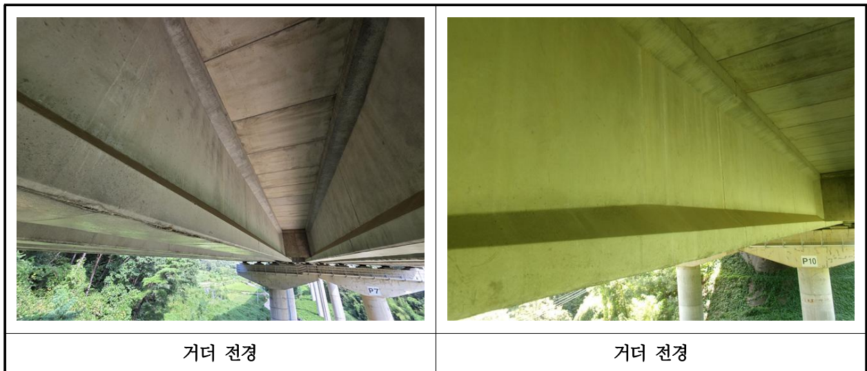
【사진 11.3.31】 거더 전경
