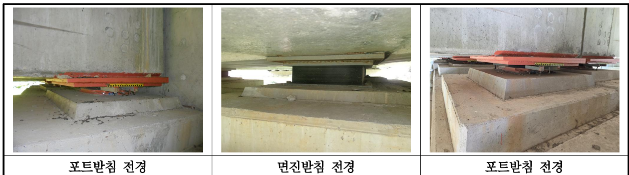
【사진 11.3.13】 교량받침 전경
