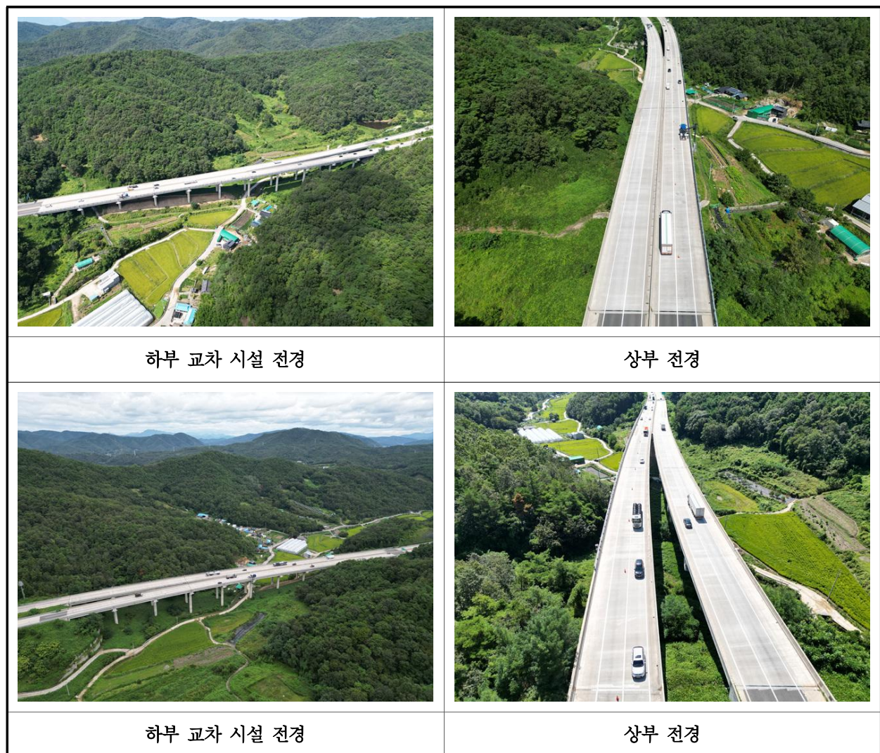
【사진 11.2.2】 주변환경 및 하중변화 전경
