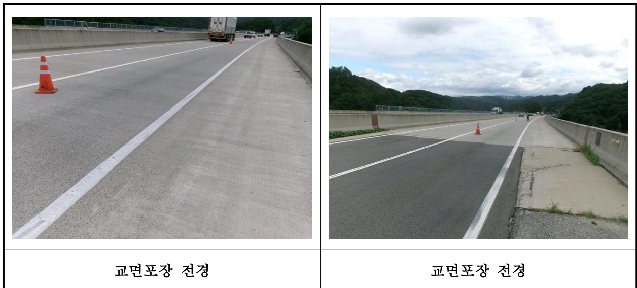
【사진 11.3.47】 교면포장 전경
