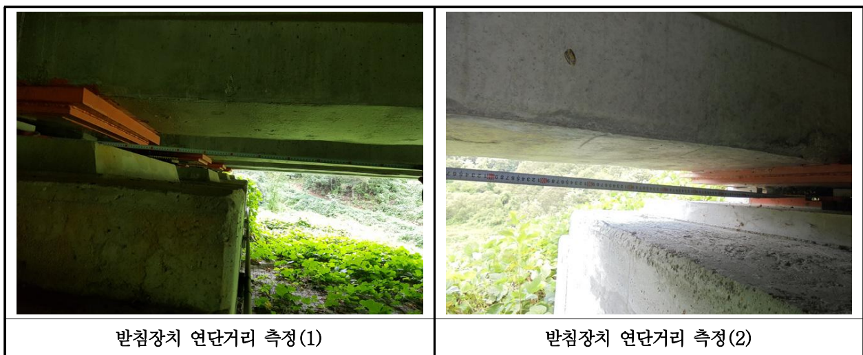
【사진 11.3.42】 교량받침장치 연단거리측정
