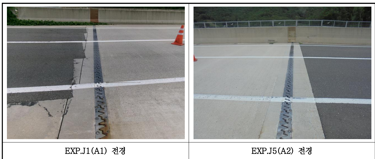
【사진 11.3.44】 신축이음장치 전경
